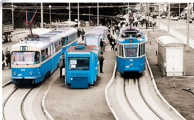
• Tramvajski dio terminala Dubrava snimljen prije puštanja u promet pruge za Dubec •
