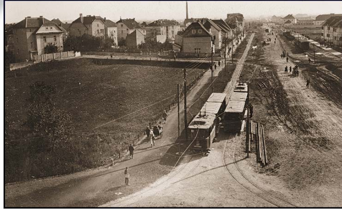
• Bivša tramvajska pruga u Sajmišnoj (današnjoj Heinzellovoj ulici) snimljena s prozora Gradskog kupališta na Kvaternikovu trgu 1926. •
