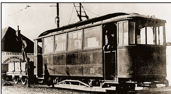
• Ganzova motorna kola iz 1911. s teretnim prikolicama na Savskoj cesti u blizini mosta •
