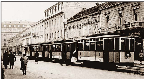
• Mandlova motorna kola M-24 snimljena u Draškovićevoj ulici kako vuku tri "pagode" kao prikolice, koje su pregrađene iz Ganzovih motornih kola iz 1910. •
