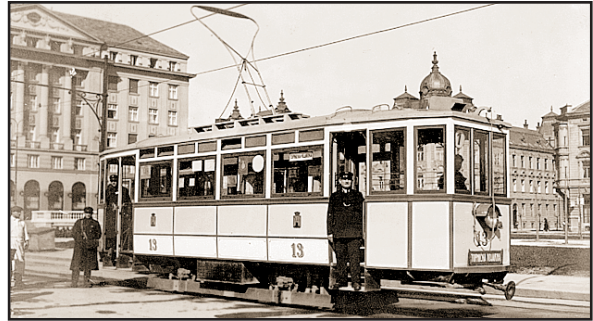
• U Zagrebu se do 1926. vozilo lijevom stranom ceste, što je naslijeđeno iz razdoblja zaprežnih vozila zbog kočijaševa položaja na kolu (a zadržala se do danas, npr. u Velikoj Britaniji). Ova Mandlova motorna kola M-24 već su prilagođena desnom stranom, jer je s desne strane vozača samo jedan ulazno-izlazni otvor •
