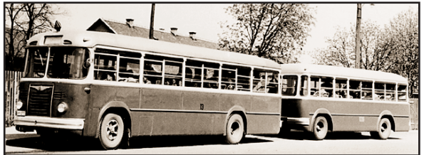
• "Alfa-Romeo" 910 AU, karoserist "Goša" S. Palanka. Od 1956. do 1958. nabavljeno 14 autobusa snage motora 130 KS i kapaciteta 2+20+65 mjesta. Autobusi su bili osposobljeni za vuču prikolice a prema prometnim propisima na prednjem dijelu krova morali su imati žuti trokut s crnim rubom, koji je bio podignut kada su vukli prikolicu. Prvih 10 bilo je plave boje s tamnoplavim krovom, a zadnja 4 crvena sa srebrnim krovom. Plavi su vukli plave, a crveni crvene prikolice. Otpisani su između 1965. i 1968. g. Na slici je crveni autobus broj 13 s prikolicom 1006 koja je sagrađena u istoj tvornici na podvozju talijanske tvrtke "Adige-Viberti", s 8 guma na dvije osovine •
