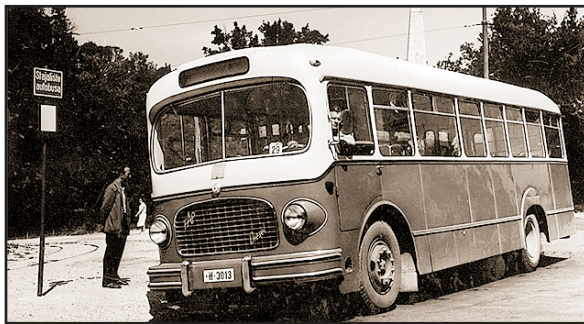
• FAP 5 GVF-UG, karoserista "Ikarusa" iz Zemuna, 1956. g., 130 KS, 2+16+60 mjesta, G.B. 71. Autobus je kupljen kao ogledni primjerak nakon čega je kupljeno još devet vozila iste marke i tipa s promijenjenom karoserijom i rasporedom sjedala (72-80), otpisan 1964. g. •
