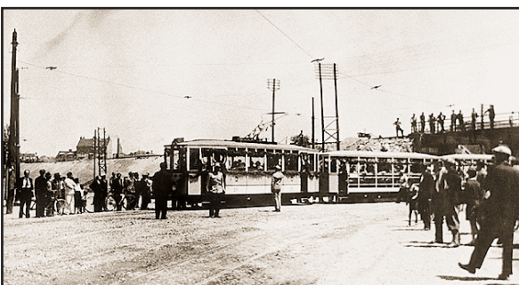
• Nova ljetna prikolica prigodom svečanog otvaranja tramvajske pruge Tratinskom cestom nakon adaptacije kojom su uklonjene bočne oplata a uvedena su sjedala s preklopnim naslonom te montirani novi viseći ogibeljni rukohvati •
