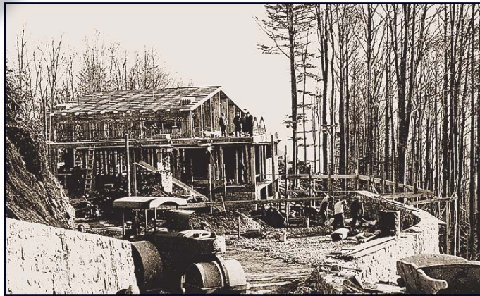
• Gornja stanica žičare u izgradnji •
