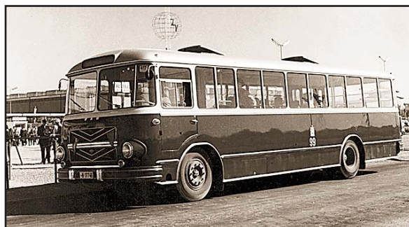
• FAP 5 GVF-St, zagrebačke karoserije, snaga motora 130 KS; 1959. nabavljeno 15 vozila, a 1960. još 11. Prosječan kapacitet bio je 15+70 mjesta. Bili su karakteristični po tomu što su imali potpuno pregrađen vozački prostor preko cijele širine vozila. Prema izgledu prednjeg dijela vozila (maska hladnjača), vidjela se je razlika u godini proizvodnje. Otpisani su 1968. i 1969. g. Autobus 116 predan je tijekom 1967. Tehničkoj kontroli tramvaja gdje je služio za ispitivanje tramvajskih elektromotora sve do 1970. •
