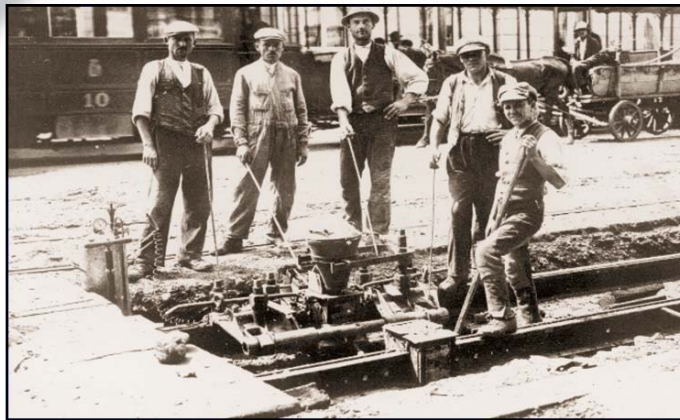
• Aluminotermičko ("termitsko") zavarivanje tračnica u Vlaškoj ulici prigodom obnove kolosijeka 1926. •
