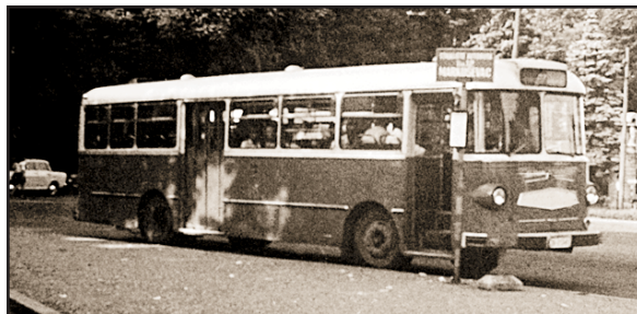
• Autobus TAM AS 3500, novosadske karoserije, snimljen u Maksimiru. Vozila s motorom snage 125 KS bila su nabavljena od 1963. do 1966. godine. Broj mjesta ovisi o godini proizvodnje, nabavljen je 51 autobus, a u prometu su bili do 1973., odnosno 1975. g. •
